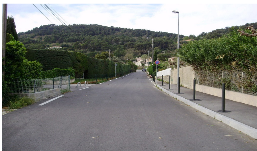
Vue identique en avril 2012, le chemin d'exploitation de 2m de large est devenu l'Allée Yves du Manoir de 6m et de nombreuses habitations ont été construite autour de cette parcelle AM494.
